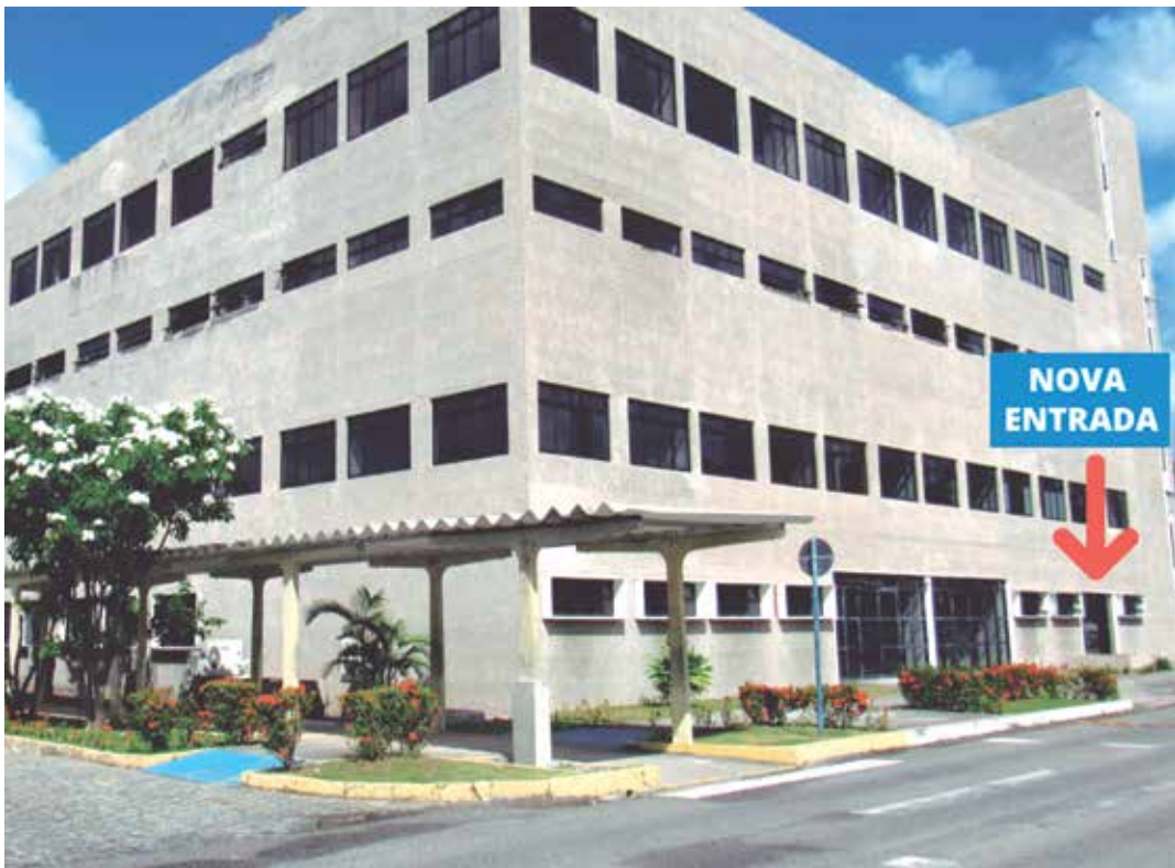
Nova entrada e os corredores que fazem comunicação com as unidades já foram liberadas
