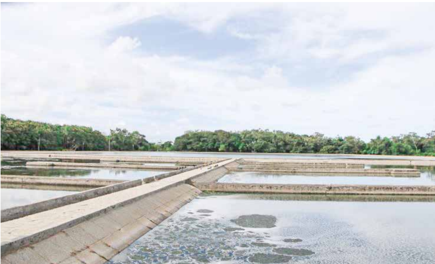
A geração da energia elétrica deve ser produzida a partir do biogás liberado pela Estação de Tratamento de Esgoto (ETE)
