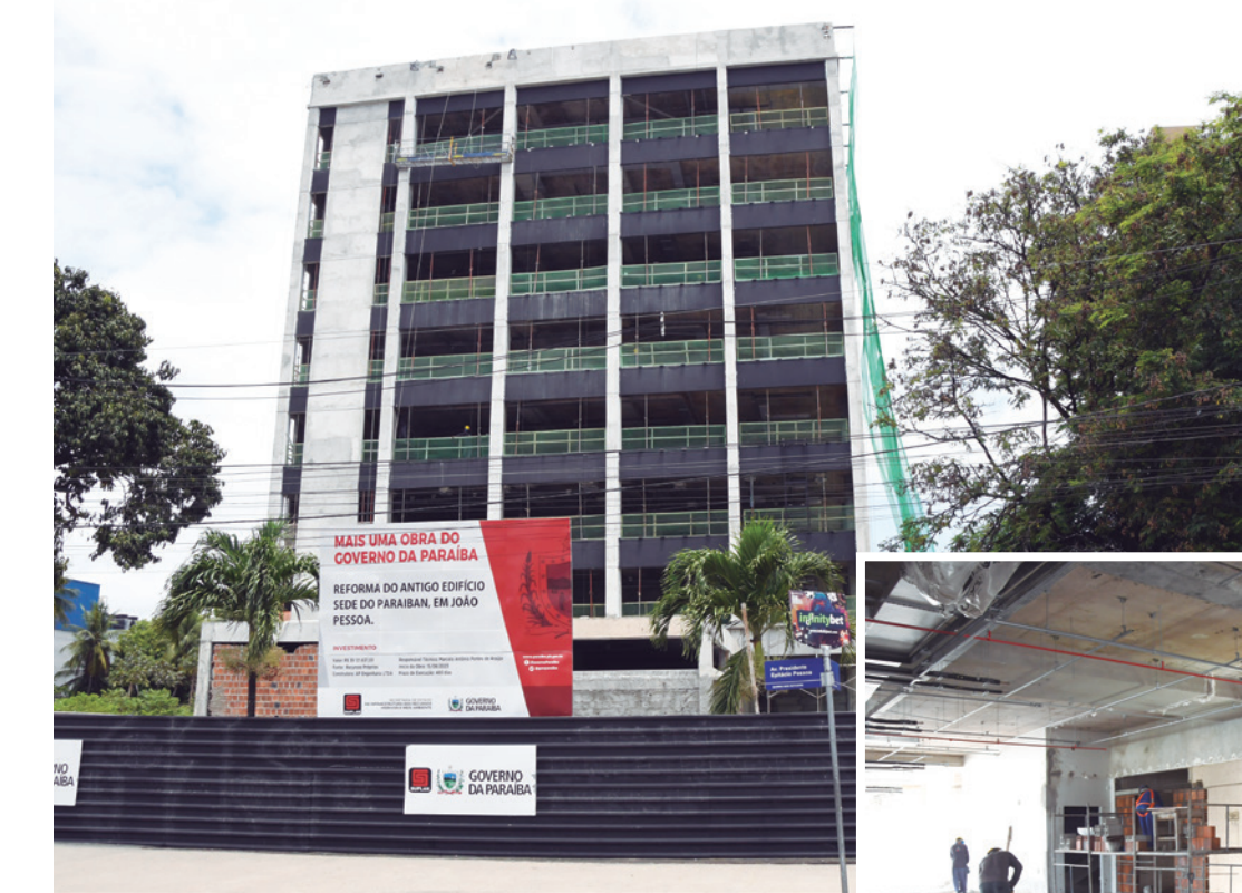
Recuperação estrutural das paredes e dos painéis, revestimento da fachada e instalação de forros, esquadrias e climatização estão entre as melhorias que a Suplan realiza no local
