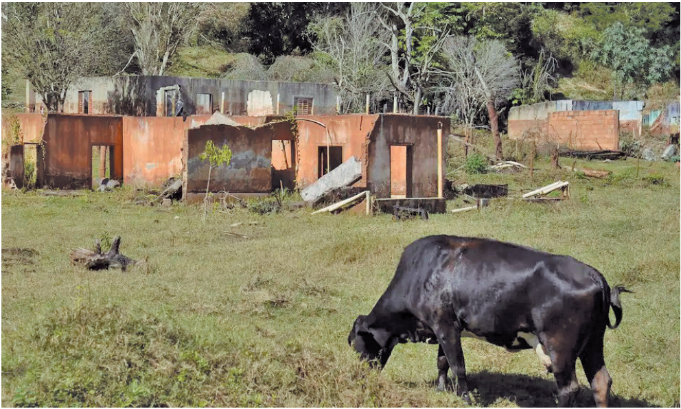
Fotos mostram a realidade hoje, o que ficou da localidade afetada com o rompimento da barragem
