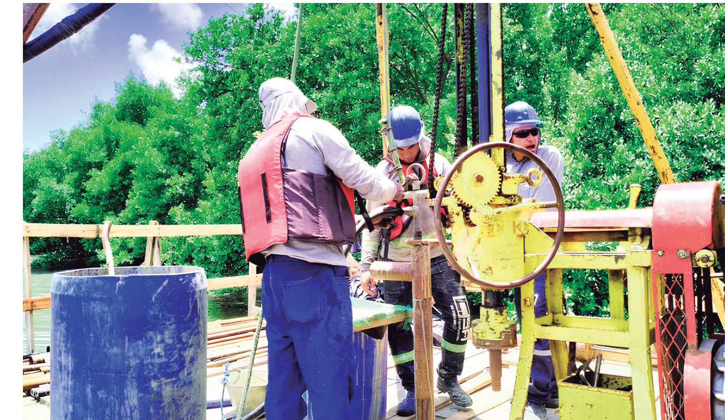
Primeira fase aconteceu em setembro passado, com avaliação da capacidade de suporte do solo por meio de sondagem geotécnica
