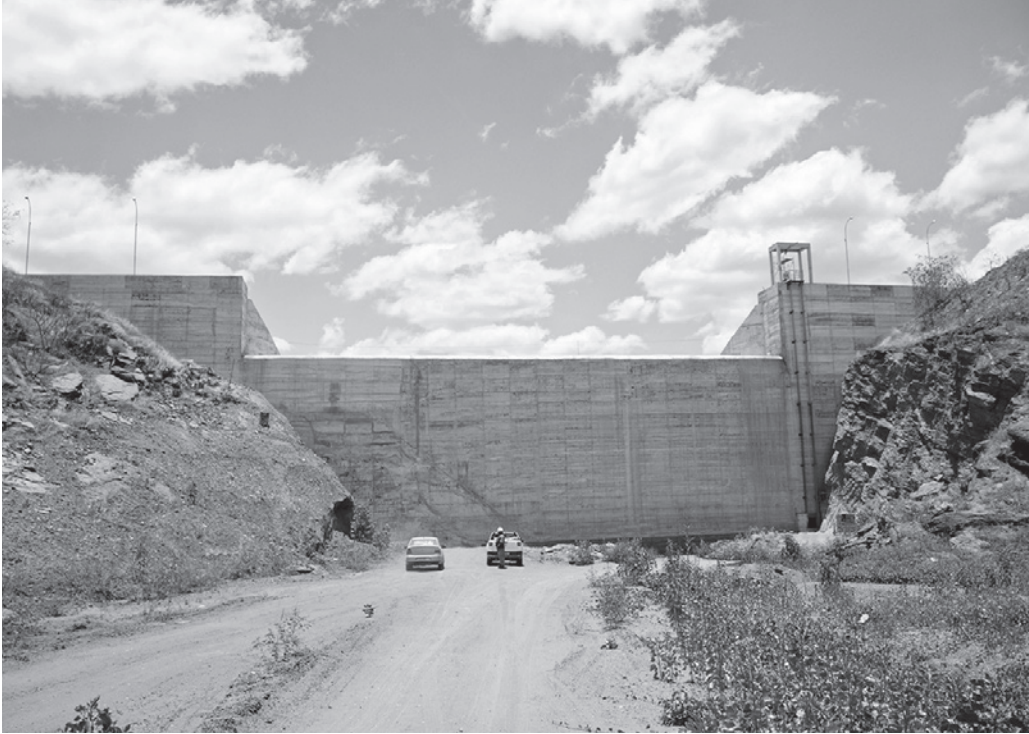
A obra da barragem Porcos está praticamente concluída, faltando apenas a parte de acabamento
