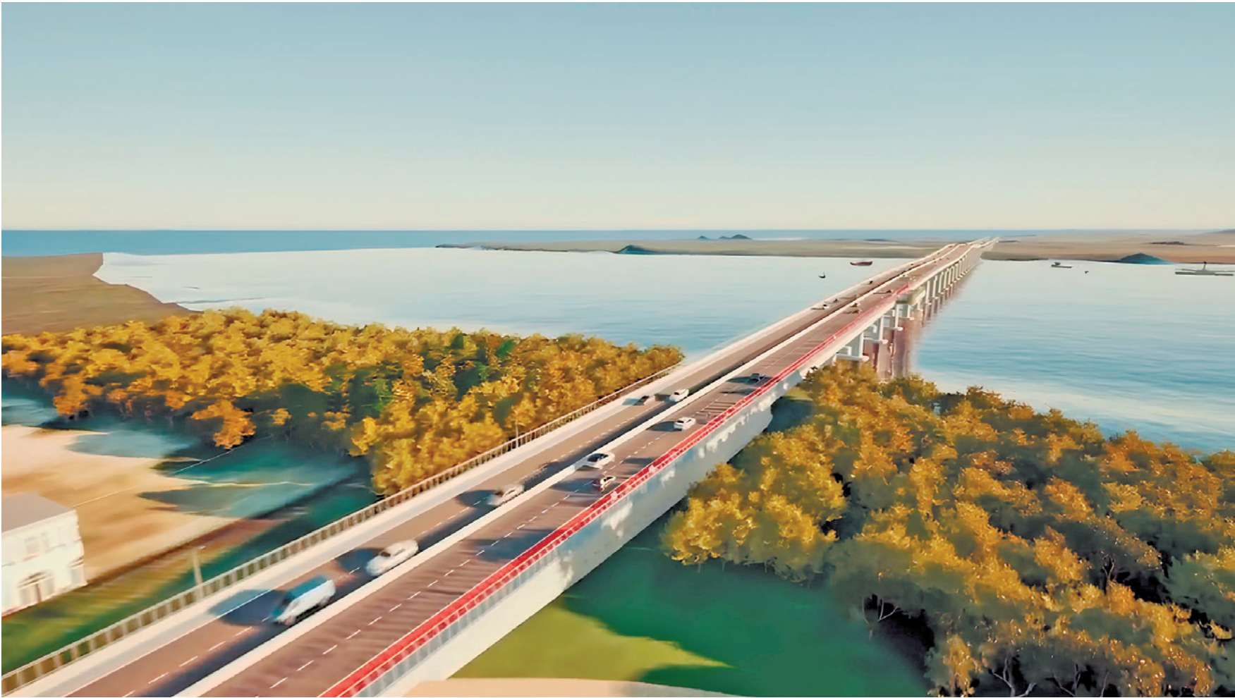
Obra terá capacidade de desviar, por dia, mais de 500 caminhões do trânsito urbano, o que diminuirá o tráfego e os índices de acidentes e de poluição ambiental
