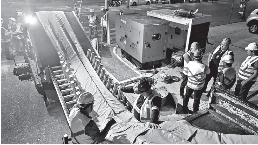
O método utilizado consiste em moldar uma nova tubulação dentro da já existente
