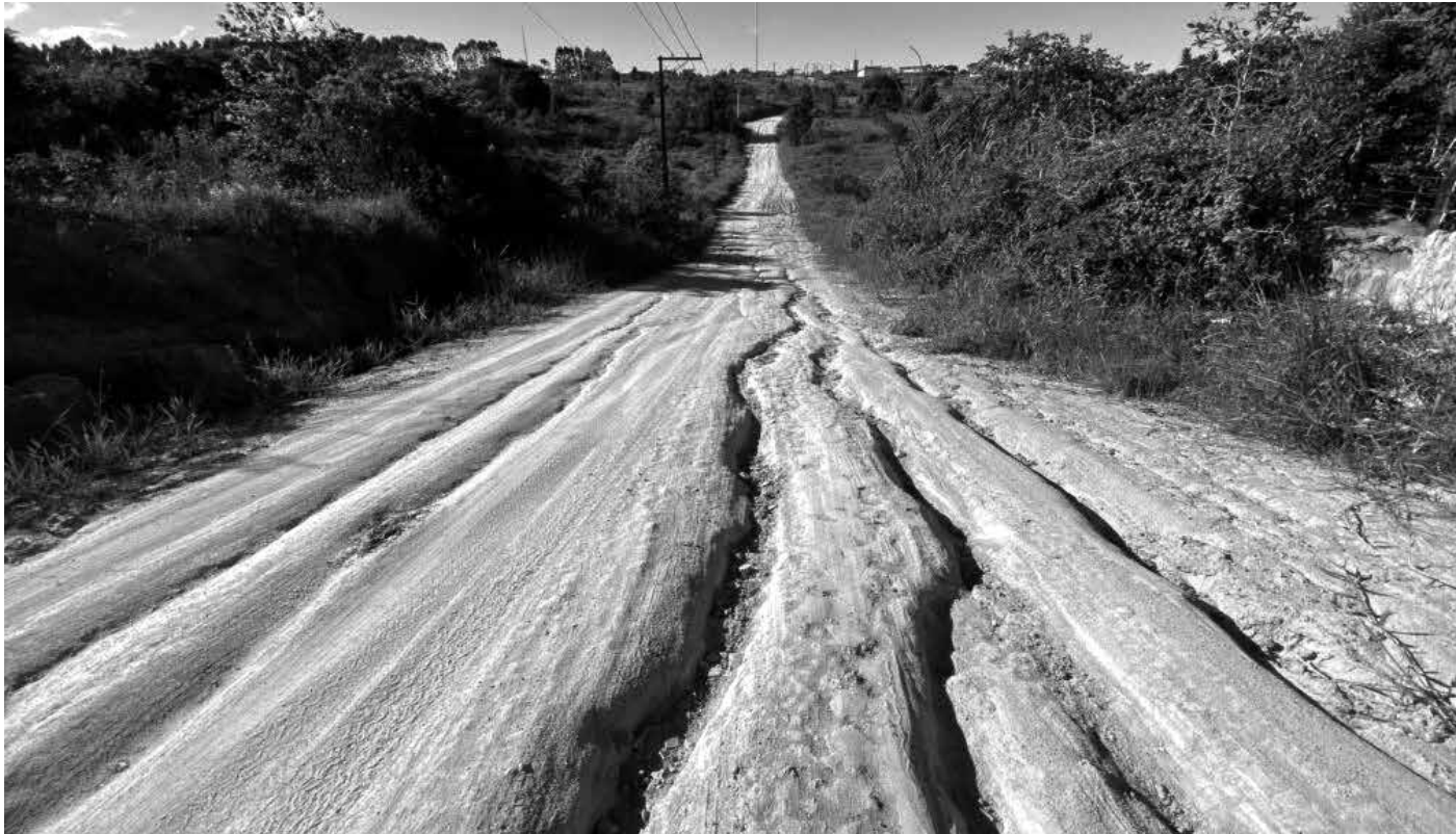
Buracos, erosões e outros problemas estruturais dificultam a mobilidade nas vias, gerando perdas de produtos e risco de acidentes
