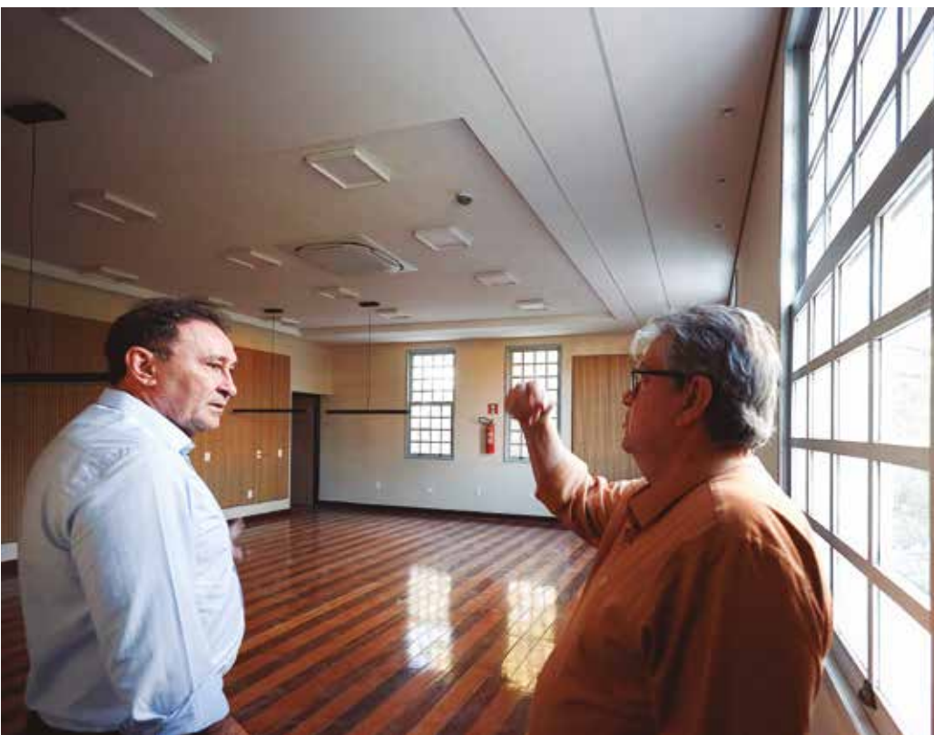
João (D) ressaltou que são mais de 30 prédios que estão sendo recuperados no Centro Histórico
