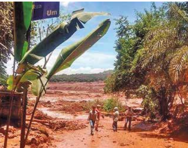
Destruição da área quando do rompimento da barragem
