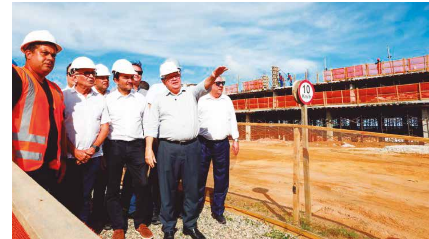
Ao lado do prefeito Cícero Lucena e do governador João Azevêdo, Celso Sabino conferiu, ontem, o andamento das obras
