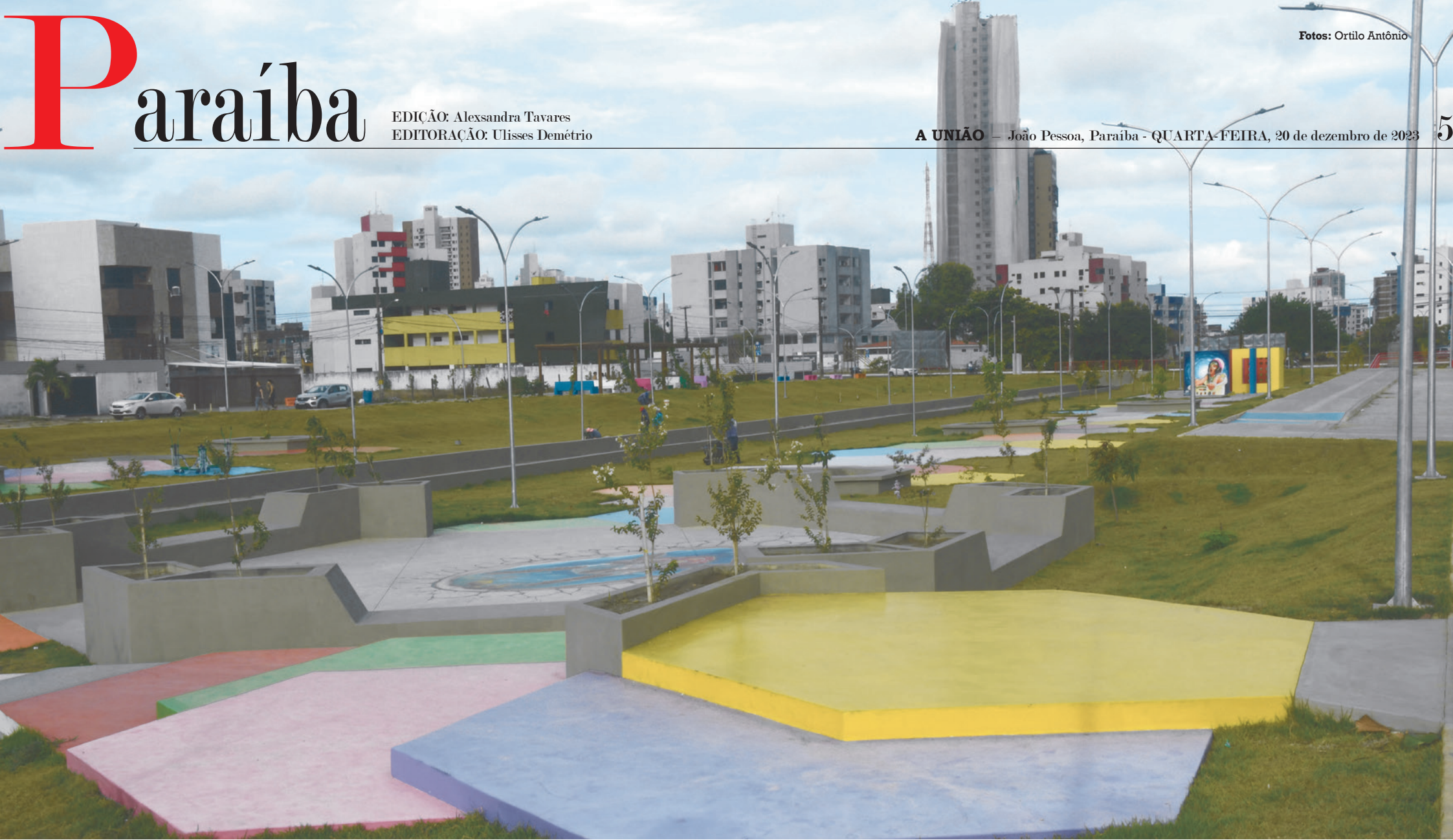
Obra, que teve início em setembro de 2022, está em fase de acabamento, com a realização de pinturas e retoques. A previsão de entrega é entre o dia 30 de janeiro e a primeira semana de fevereiro
