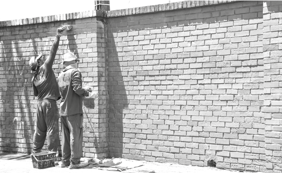
Trabalho, quer faça chuva, quer faça sol!
