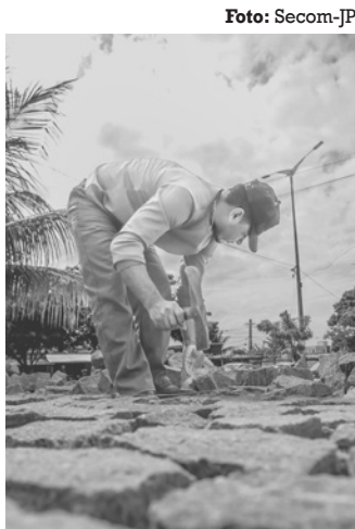
Obra em Valentina Figueiredo
