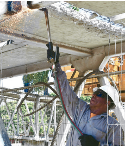
Profissionais têm realizado o desmonte das estruturas para a retirada da passarela devido ao avanço das obras do viaduto de Água Fria
