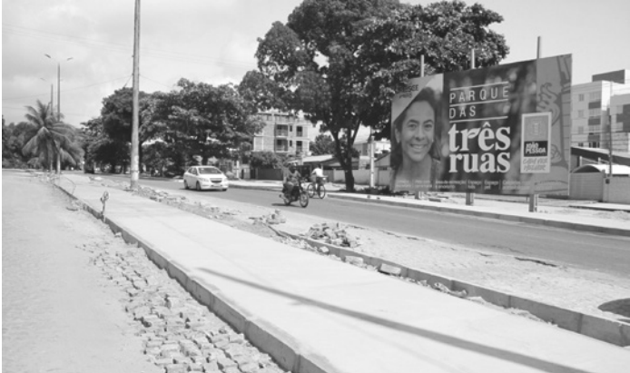
Parque das Três Ruas está com 45% dos trabalhos executados
