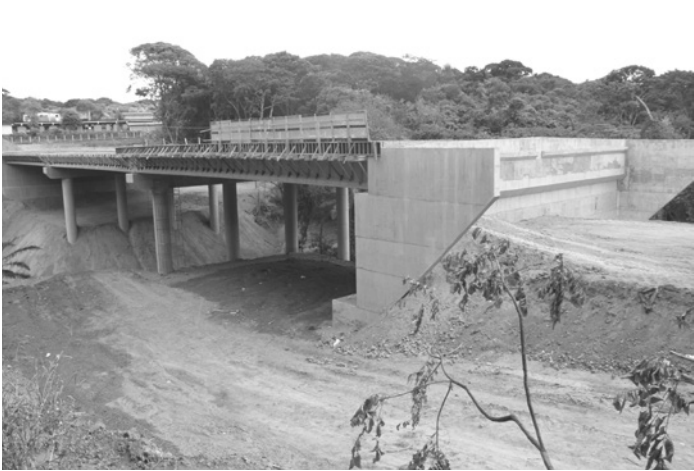
Atualmente estão em execução as armaduras da laje superior
