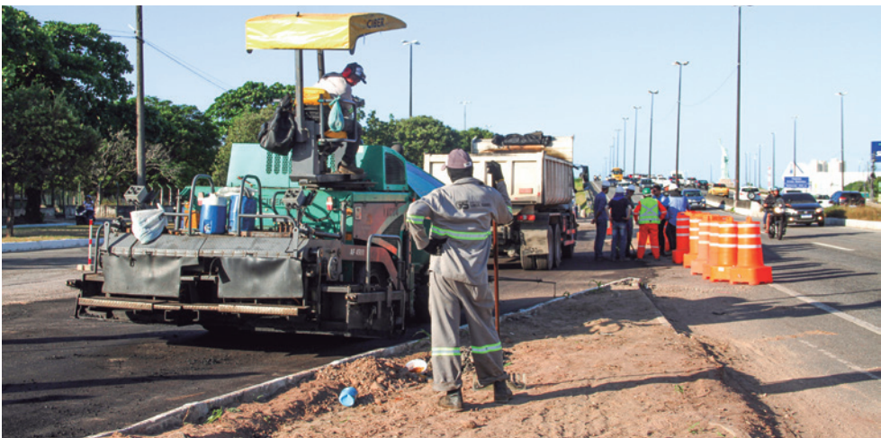
Obras no novo desvio já estão adiantadas, com a colocação de asfalto e sinalização
