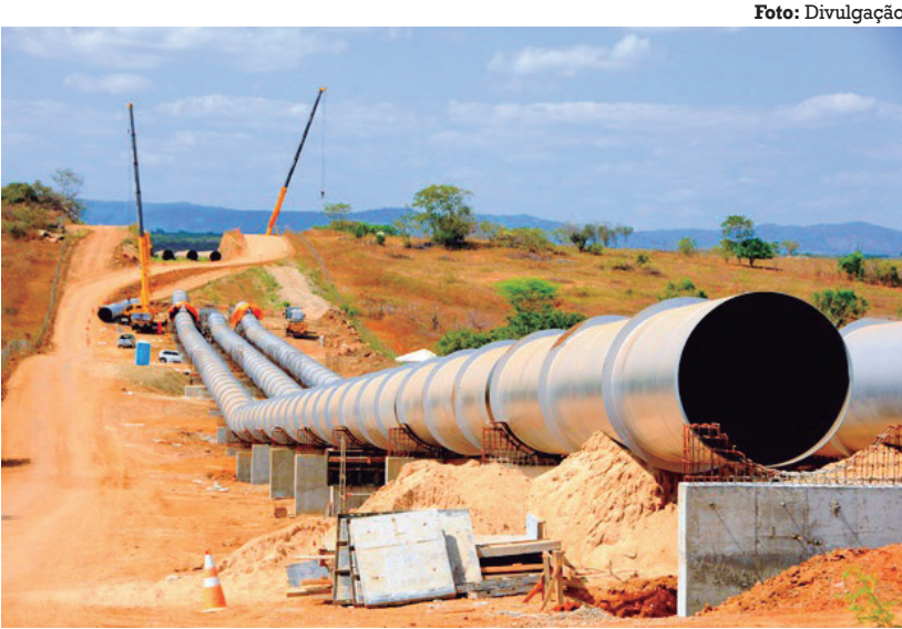
Canal Acauã/Araçagi é uma das maiores obras em andamento na PB
