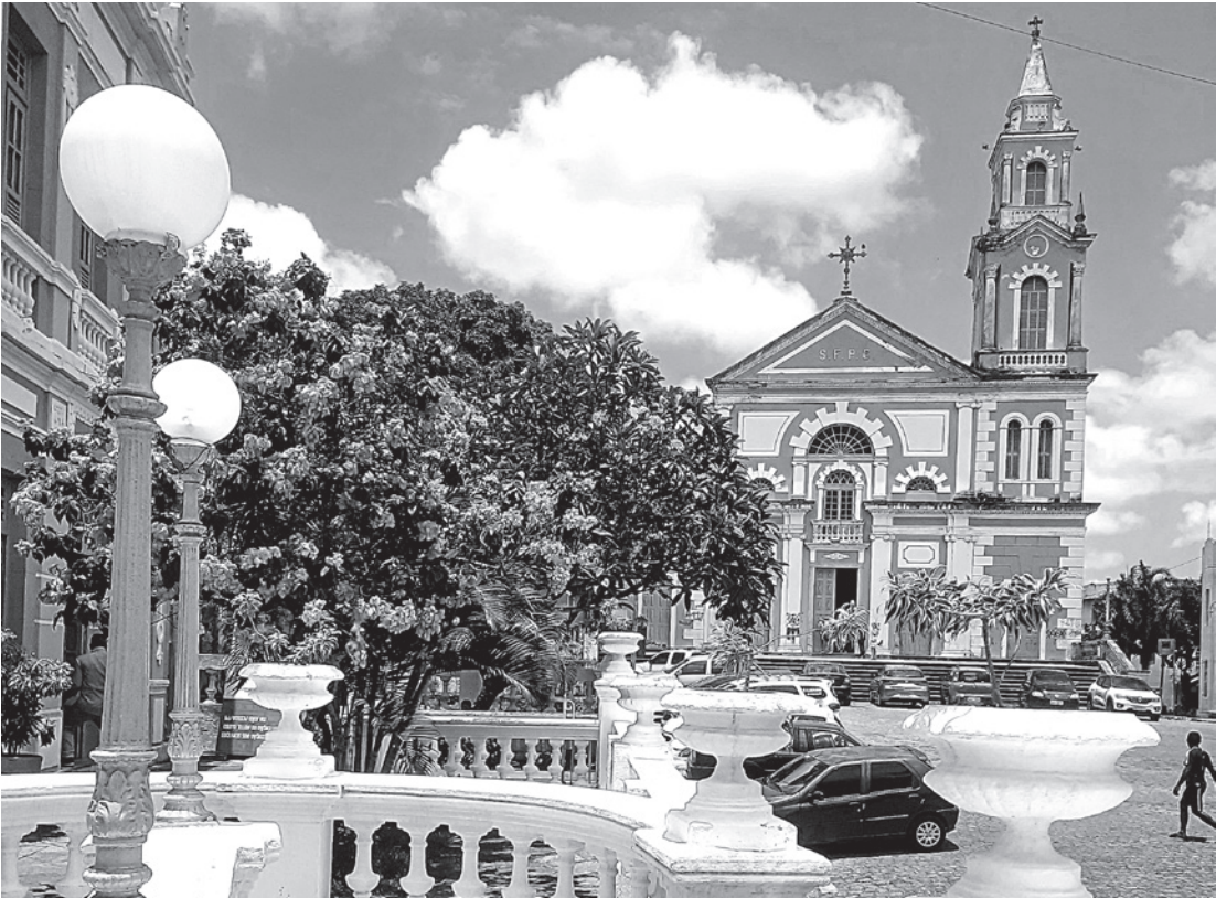
Igreja de São Frei Pedro Gonçalves
