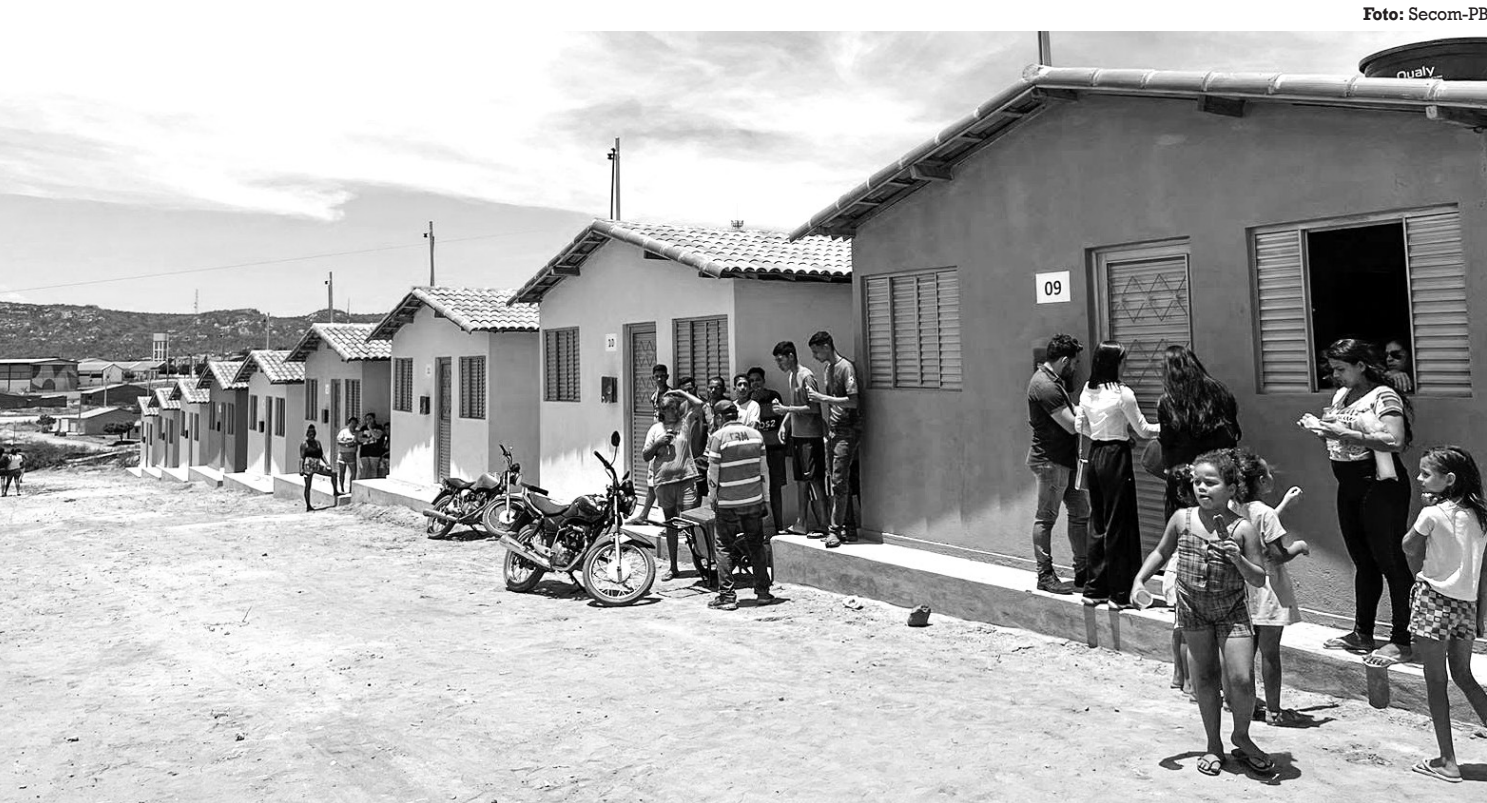
Unidades habitacionais têm revestimento cerâmico no piso e nas áreas molhadas, além de rede de esgotamento sanitário
